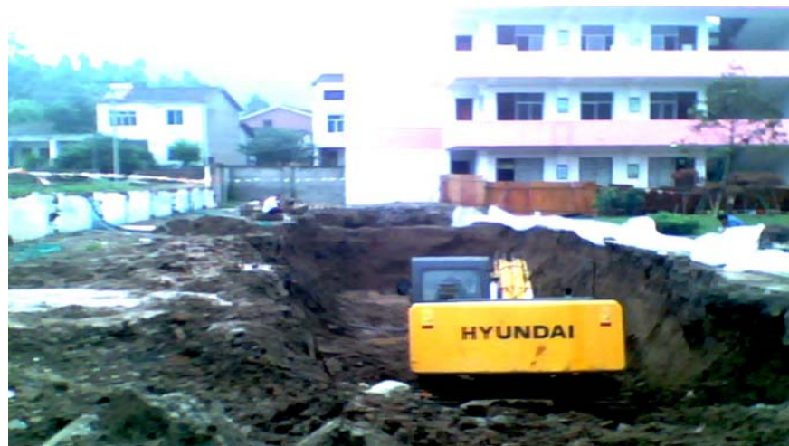
正在作业的挖掘机
