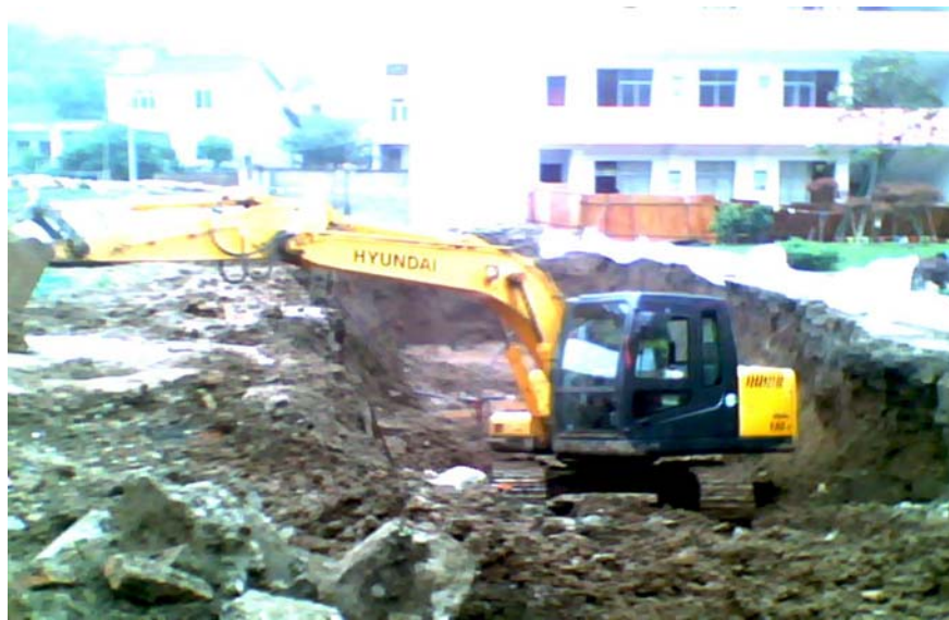
正在作业的挖掘机
